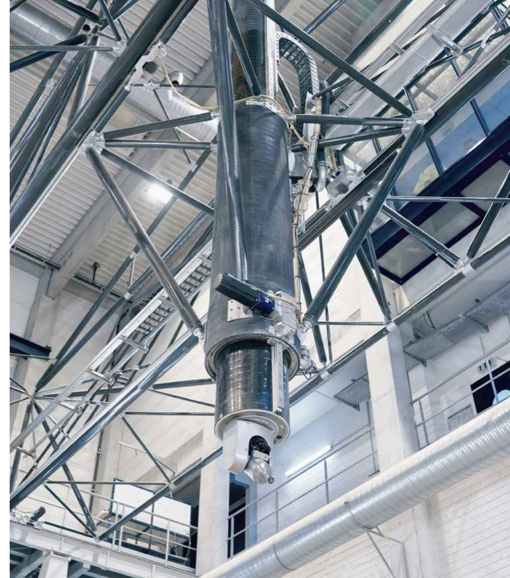
El pórtico completamente renovado mecaniza la zona inferior de las piezas de aprox. 1 a 4 m de altura.
